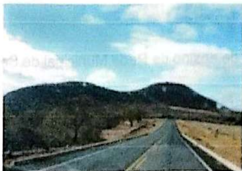
Figura 16 - Vista da PI-459, rodovia de acesso ao município por Paulistana.
