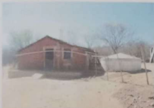
Figura 13 - Casa em adobe e telha cerâmica, com cisterna, no povoado Mulungu, zona rural de Betânia do Piauí
