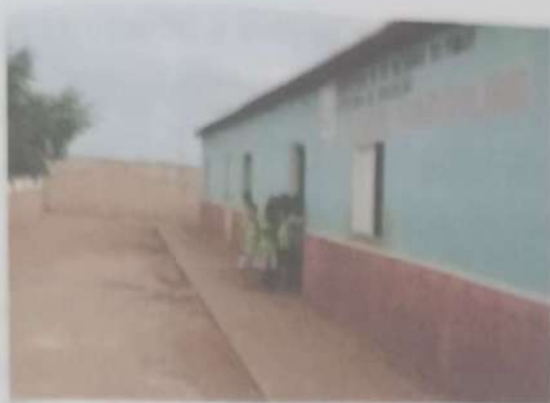
Figura 21 - Vista de colégio na Zona Rural
