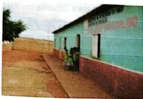
Figura 18 - Vista de colégio na Zona Rural.
