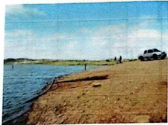
Figura 27 - Barragem Juazeiro Grande localizada próximo a sede.
